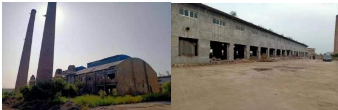
图 27-1 项目改造前照片
