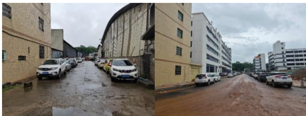
图 14-3 大岭工业园改造前后对比（建设中）
