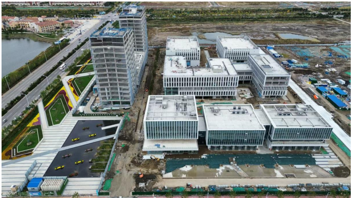
图11-2 青龙湖数据生态中心项目现状图
