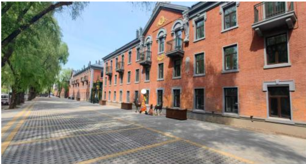
图 7-2 改造后整体建筑风貌（正面）
