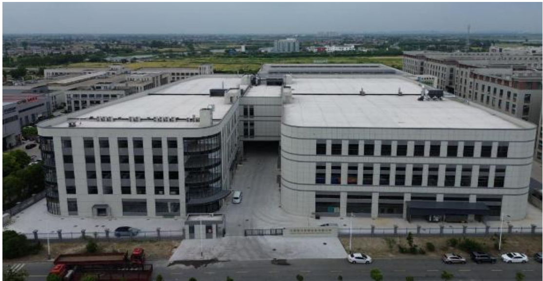
图 25-2 同力空调改造后实景图
