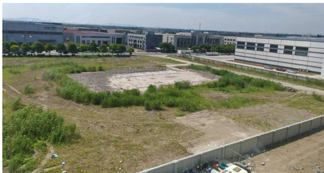
图 25-1 同力空调改造前实景图
